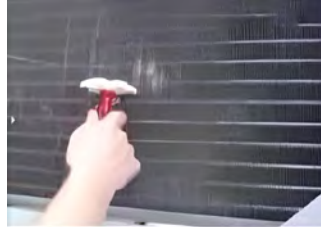
Şekil 3.18: Kondenser ünitesinin lamellerinin düzeltilmesi
