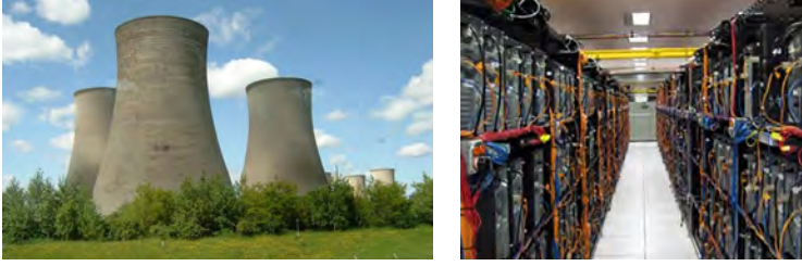
Şekil 2.9: Enerji santrallerinde ve IT merkezlerinde endüstriyel soğutma
