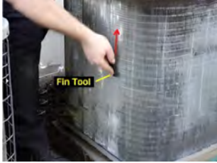
Şekil 3.18: Kondenser ünitesinin lamellerinin düzeltilmesi
