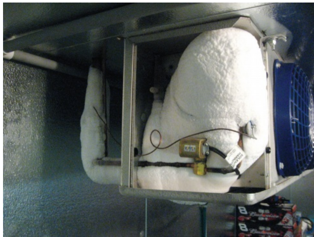
Şekil 3.20. Evaporatörlerde defrost
