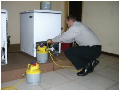
Şekil 5.152 - Geri toplama silindirinin bağlanması
